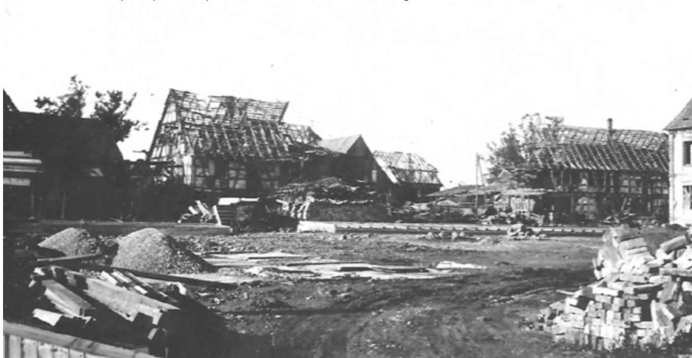
Les travaux commencent sur la rue Principale
