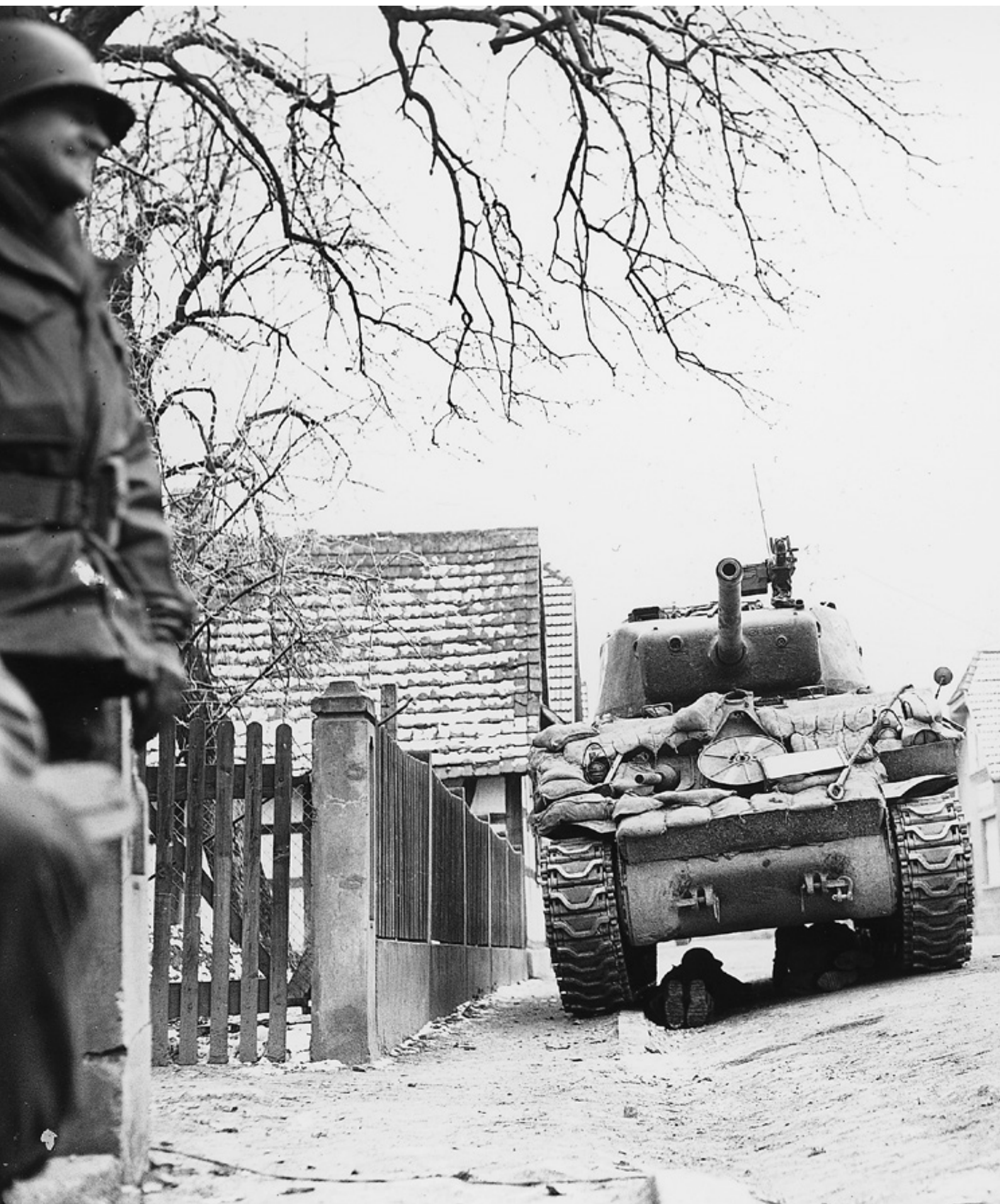
Une progression difficile face à une résistance acharnée (photo prise à Rohrwiller)
