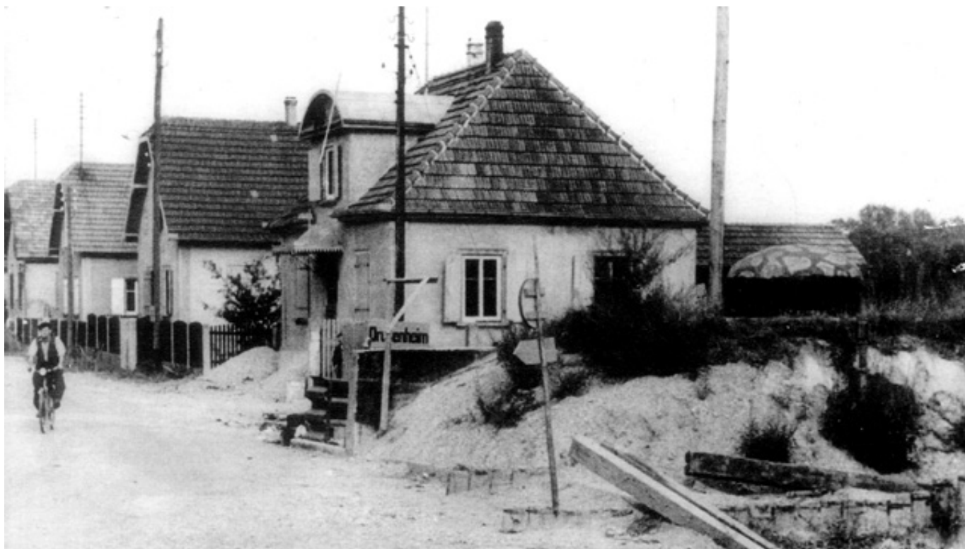
Bunker de la ligne Maginot à Drusenheim, août 1940
