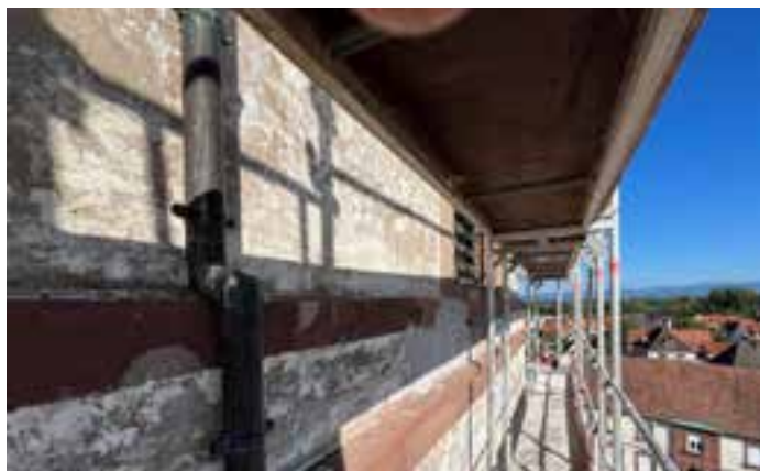
Anciennes pièces en grès des Vosges à remplacer
