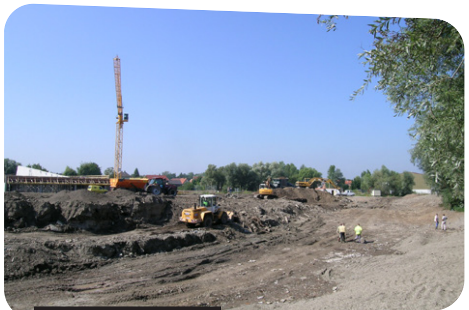
Les Jardins de l'Altwasser en travaux
